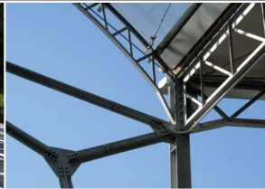
Dettaglio copertura di area comunale, destinata a servizi pubblici - Agropoli (SA)
