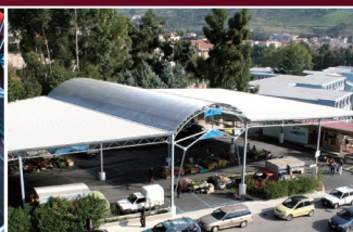
Copertura di area comunale polivalente, destinata a servizi pubblici - Agropoli (SA)
